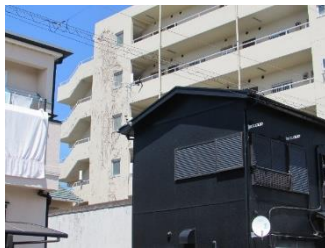
写真上左：ツタ除去前 写真上中：作業直後（残っています） 写真上右：約3週間後の様子 （自然に枯れました） 写真下左：通路の天井に伸びたツタ 写真下右：作業直後
