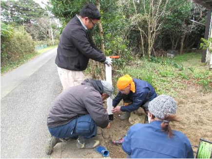
▲水平器も使ったの門柱すえつけ作業▲
