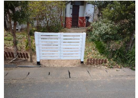
▲完成した門扉
