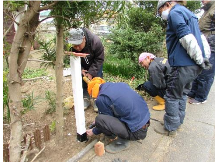
▲水平器も使ったの門柱すえつけ作業▲
