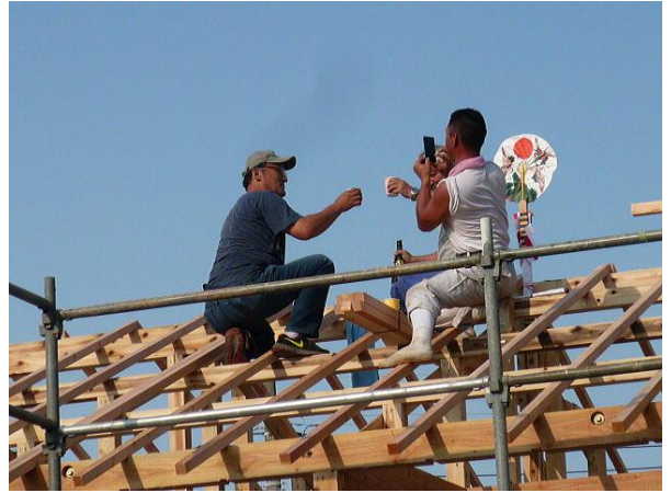
▲工事関係者と上棟式を行う田村さん
