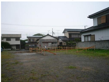
▲7月7日（工事開始直後）
