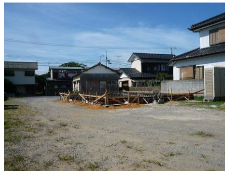
▲7月19日（基礎工事中）
